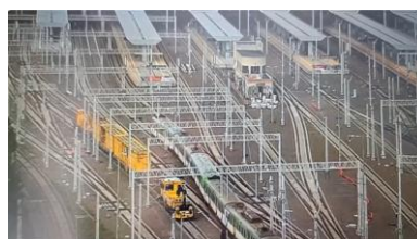
Rys. 12. Zdjęcia ukazujące skierowanie pociągu KM 21474 Dęblin – Błonie na niewłaściwy tor w dniu 05.06.2024r. [14]
