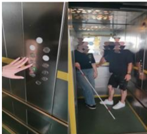
Rys. 5. Winda w budynku WM
