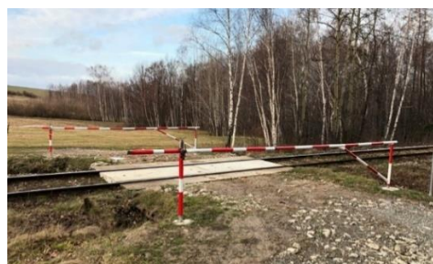
Rys. 6. Przejazd kolejowo-drogowy kat. F [oprac. własne]: na linii kolejowej nr 117: Kalwaria Zebrzydowska Lanckorona – Bielsko – Biała Główna
